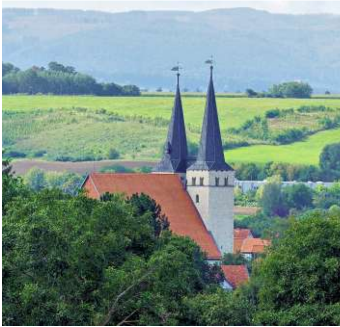
Die Stephanikirche ist nicht nur das älteste Bauwerk der Stadt, hier stand auch die Wiege des Ortes. Foto: Heinicke
