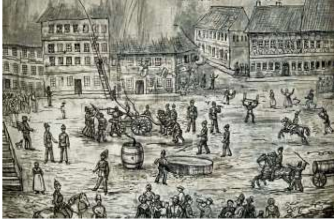
Ein Foto aus der Feuerwehrchronik: Nach dem Stadtbrand 1884 wurde die Freiwillige Feuerwehr Osterwieck gegründet. Foto: Repro Heinicke
