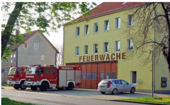
Den 100. Geburtstag als Feuerwache wird dieses Gebäude wohl nicht mehr erleben. Derzeit entsteht ein neues Gerätehaus. Foto: Heinicke
