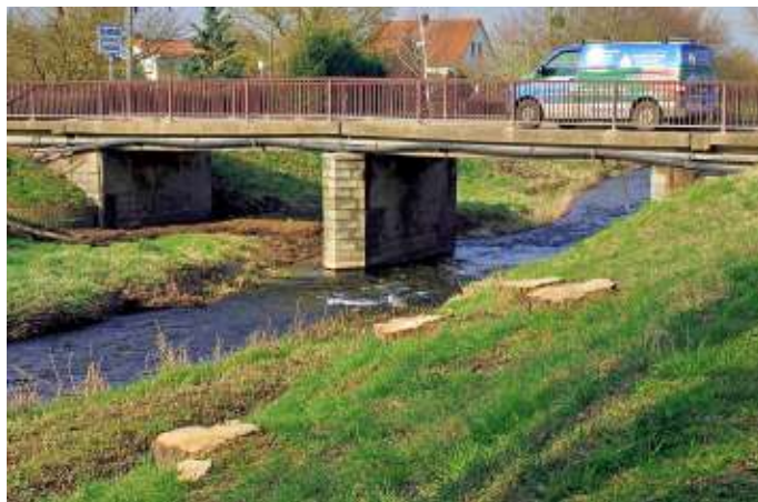
Baumstümpfe lassen erkennen, wo während des Brückenneubaus die Umfahungsstrecke hergerichtet werden soll. Foto: Heinicke
