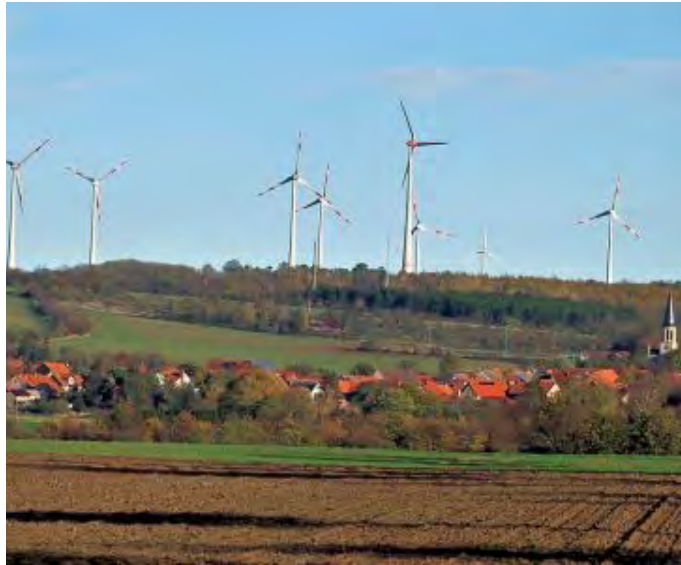
Der Windpark Druiberg mit Sitz in Dardesheim betreibt 37 Windkraftanlagen mit einer installierten Leistung von 82 Megawatt. Diese produzieren im Jahr rechnerisch ausreichend Strom, um das 40-Fache des Dardesheimer Bedarfs zu decken. Foto: Mario Heinicke
