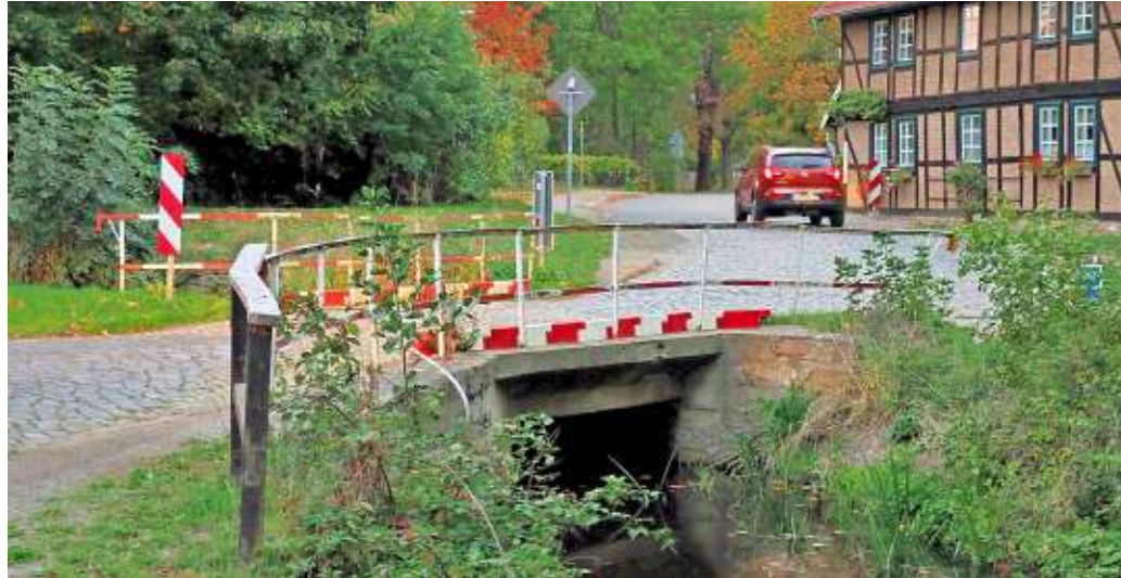
Die alte Eckergrabenbrücke wird 2023 durch einen Neubau ersetzt.
