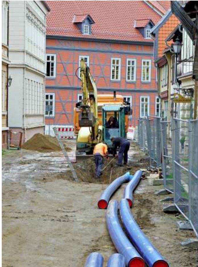
In der Tralle werden derzeit neue Wasserleitungen verlegt. Schon bald kann die Gestaltung von Fahrbahn und Gehwegen beginnen.
