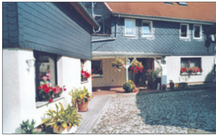
Das Grundstück Osterwiecker Straße 78
