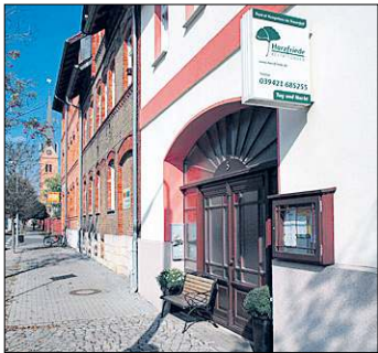
Der Sitz der Osterwiecker Filiale ist im Gebäude Teichdamm 5.
