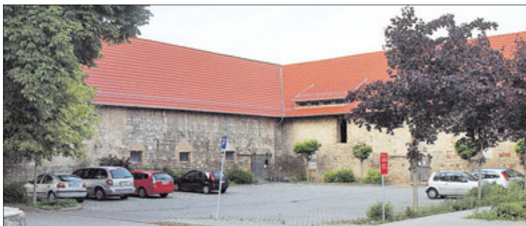
Das ist das alte Stallgebäude am Deersheimer Edelhof für den geplanten Dorfladen (rechter Flügel) und eine Markthalle (linker Flügel). Das Dach ist dieses Jahr neu gedeckt worden, ein dritter geförderter Bauabschnitt soll bald folgen. Danach wären die baulichen Voraussetzungen geschaffen, dass eine Genossenschaft von Deersheimer Bürgern den Ausbau des Dorfladens in Angriff nimmt.
