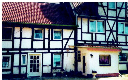
Berßel Nr. 113, die Ursprünge der Tischlerei.
