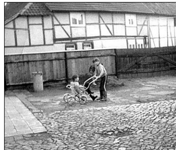
Ansicht des alten Hauses Nr. 85.
