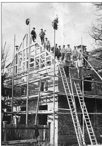
Richtfest an der Hoffmeisterschen Mühle.
