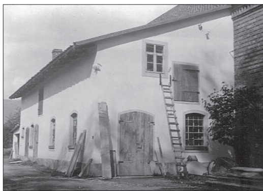
Hier arbeitete die Firma Bosse.
