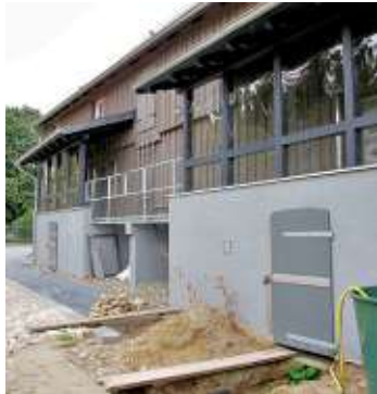
Das Gebäude 32b in der Östernstraße ist fertig saniert.
