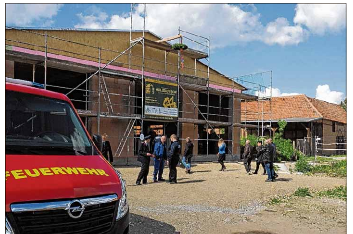
Blick auf die Garagenöffnungen des künftigen Rohrshiemer Feuerwehrhauses.
