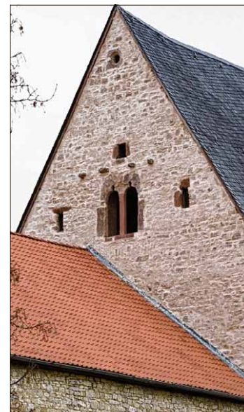
Fotos (3): Heinicke Restaurierte Nordfassade.
