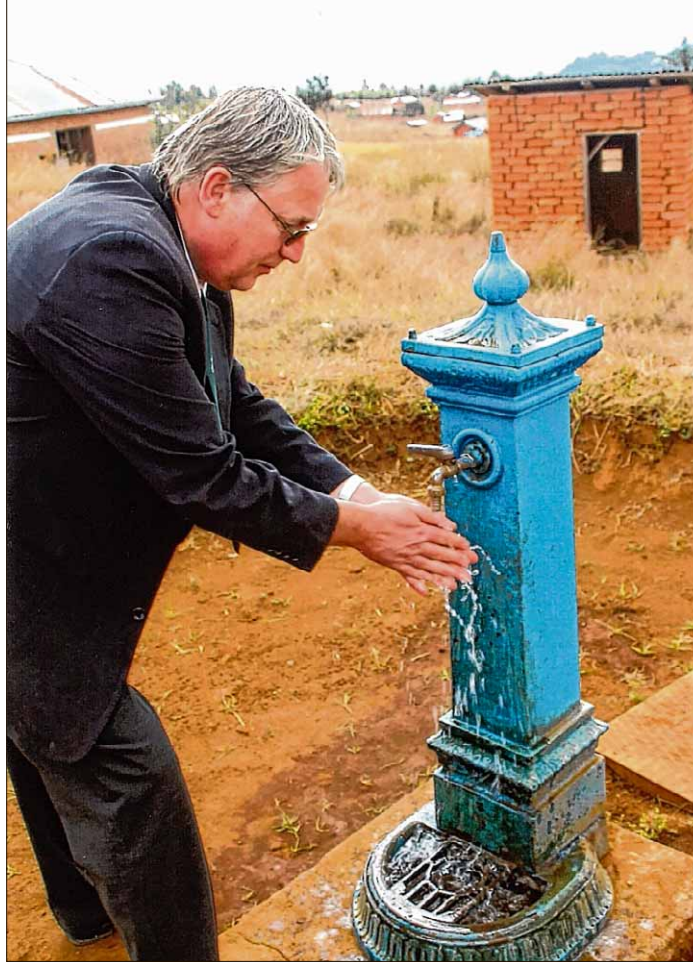
Die Zapfstelle in Makangalowe konnte mit Spendengeldern aufgebaut werden.
