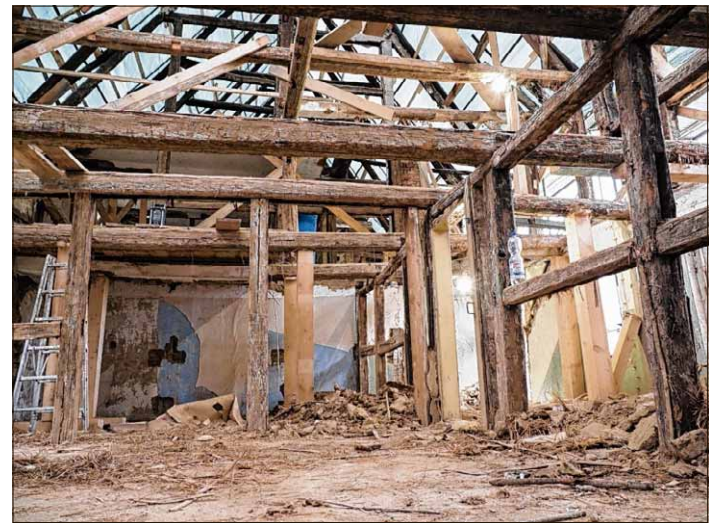
Blick in einen entkernten und statisch notgesicherten Teil der „Tanne“, wo seit einem Vierteljahr gearbeitet wird. Fotos (2): Heinicke
