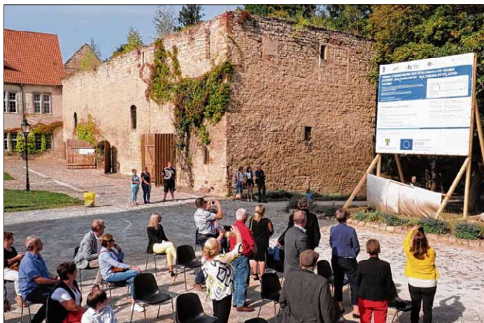
Auf Schloss Hessen wurde am Denkmaltag das Bauschild für den Ausbau der alten Steinscheune enthüllt.
