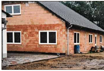
Rohbau des Berßeler Schützenhauses.
