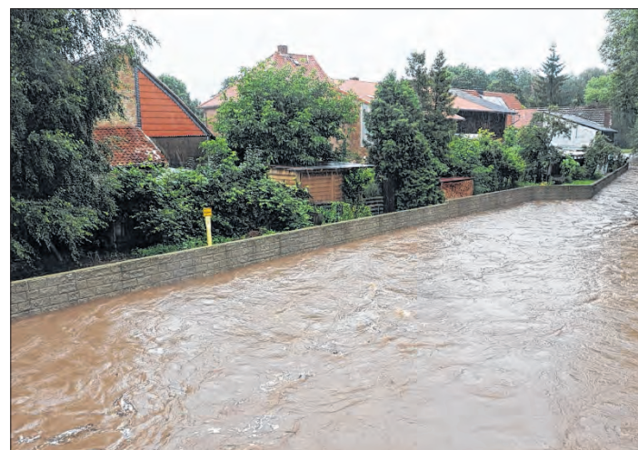
Diese Mauer vor der Wasserlebener Brücke in Berßel hat im Juli einen Teil des Dorfes vor einer erneuten Überflutung geschützt.
