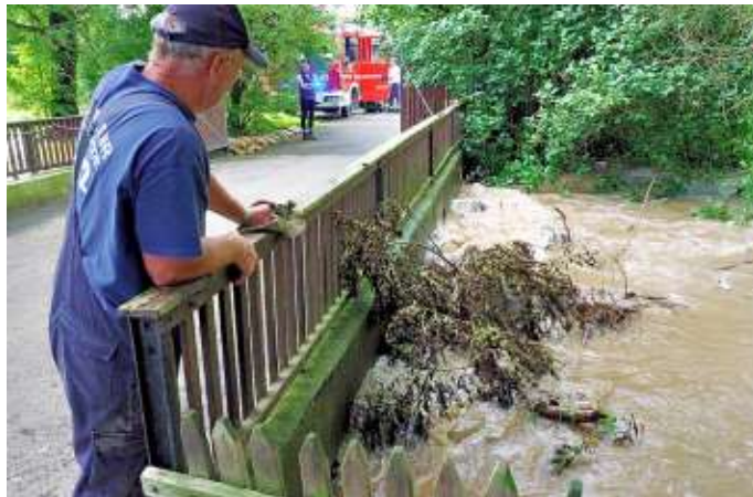
Auch beim Ilse-Hochwasser 2017 musste Brücken wie hier in Hoppenstedt beobachtet werden. Foto: Mario Heinicke
